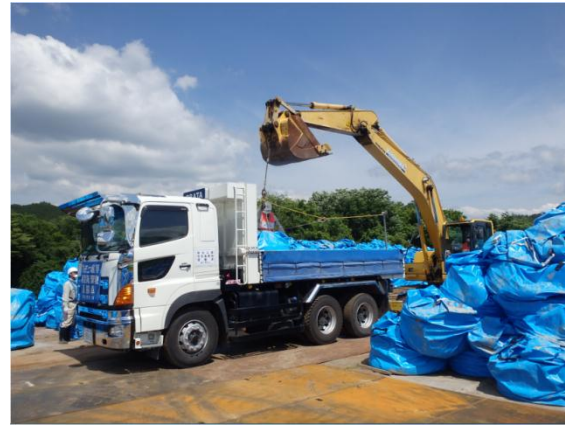
除去土壌の積み込み作業
