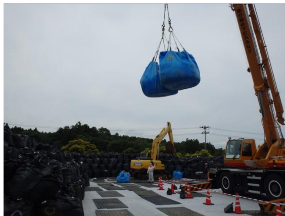
除去土壌の積下ろし作業
