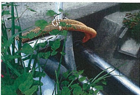
①排水路内
