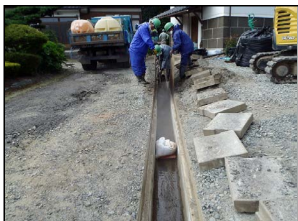
側溝の高圧洗浄
