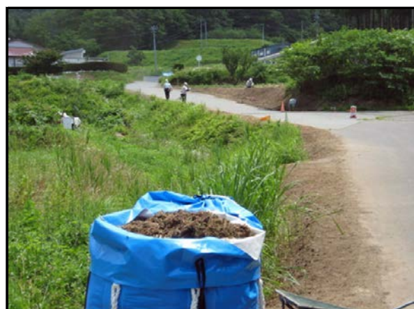
道路除染状況
