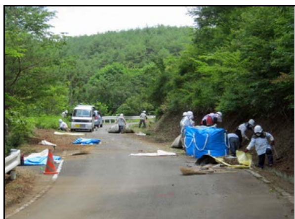
道路除染状況
