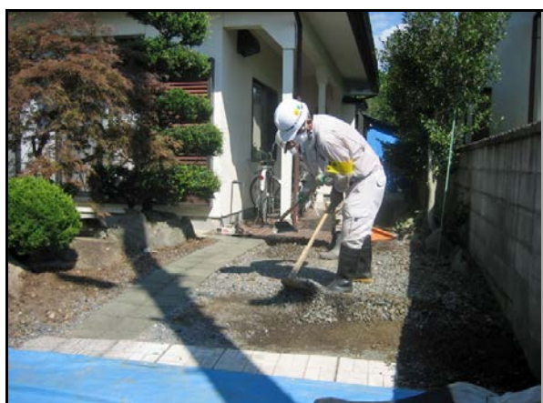
砂利・碎石の除去
