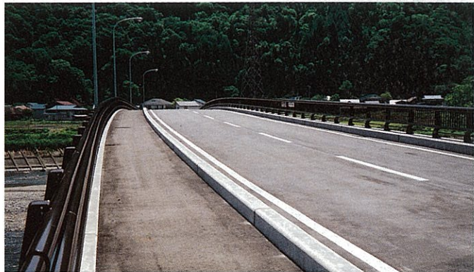
伊南川に架かる橋
