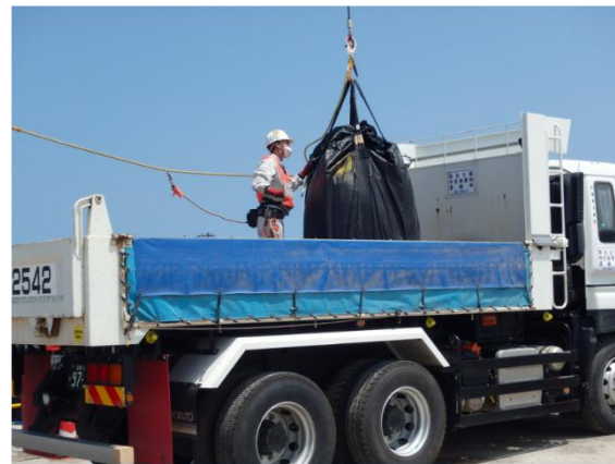
除去土壌の積み込み作業
