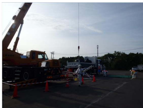
除去土壌の積下ろし作業
