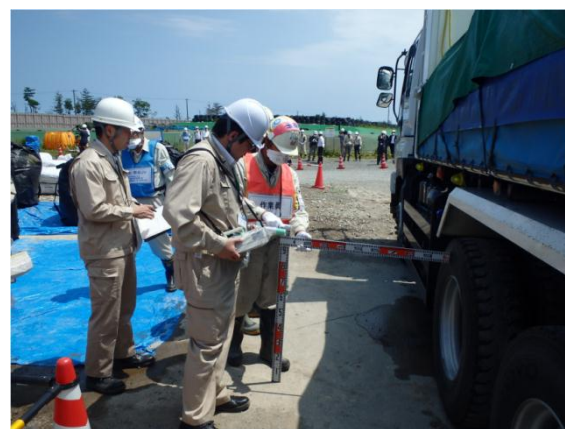
運搬車両の空間線量率の測定
