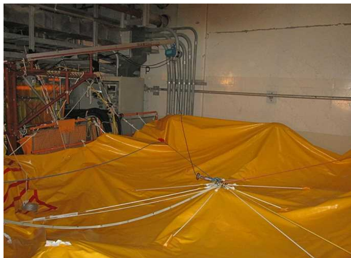
2014年6月の設置状況
