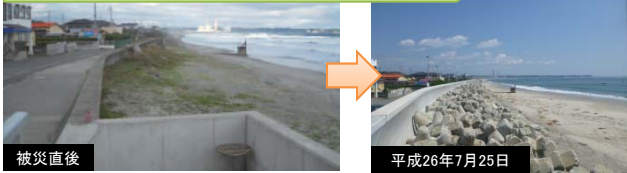
海岸堤防のかさ上げ工事（いわき市勿来町）
