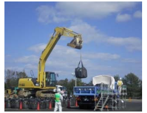
積み替え作業
