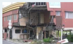
震災による建物破壊 (富岡駅前)
