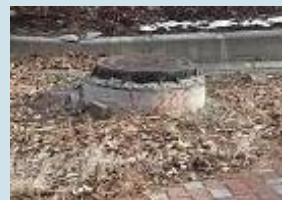
マンホール隆起や液状化の再現展示
