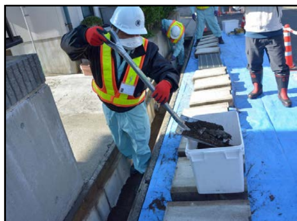
道路除染での側溝堆積物の除去作業
