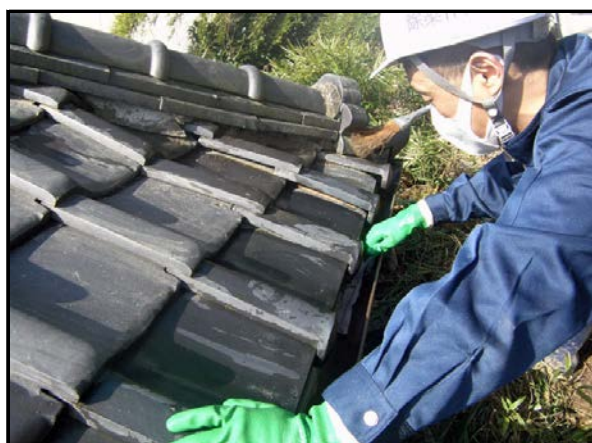
屋根拭き取り状況
