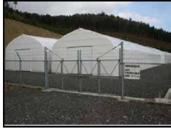
仮置場（入り口側から撮影）
