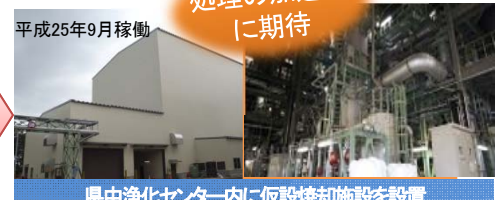
県中浄化センター内に仮設焼却施設を設置
