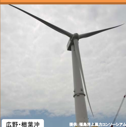
広野・楢葉沖 提供: 福島洋上風力コンソーシアム
