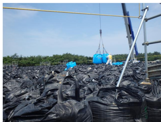
除去土壌の積下ろし作業
