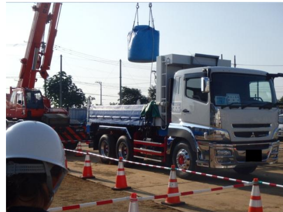
除去土壌の積み込み作業
