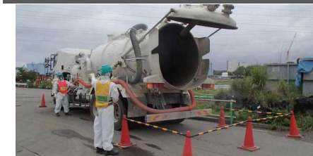
コーンバーによる安全区画の実施
