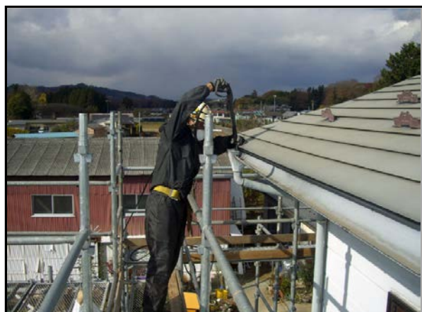
縦樋除染作業状況
