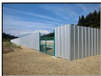
仮置場での遮へい作業
