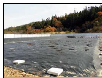
完成された仮置場
