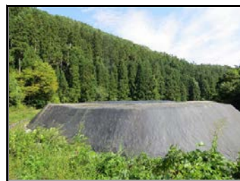
高内仮置場全景
