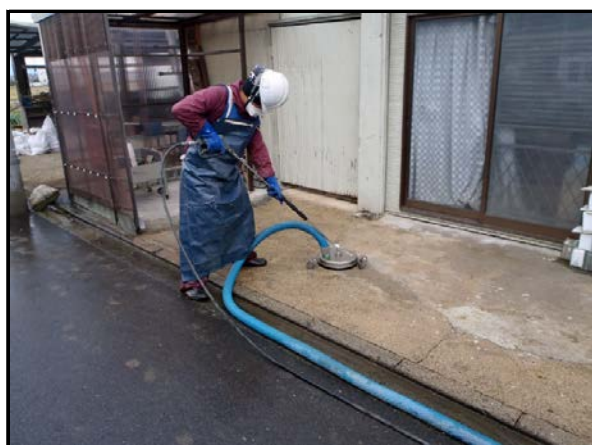
吸引型高圧洗浄によるコンクリートたたき等の除染作業
