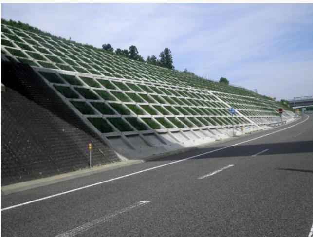
工事完成写真
