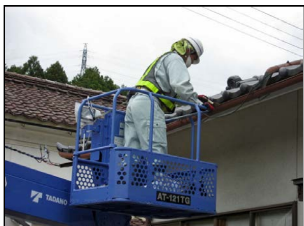
雨樋(横樋の堆積物の除去・拭き取り)の除染作業
