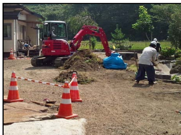
住宅敷地内の除染作業
