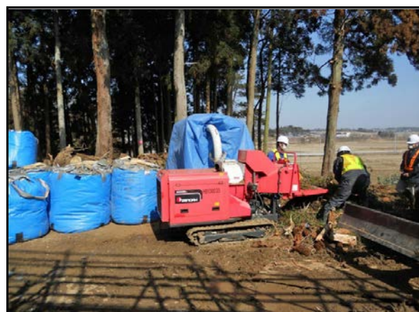
枝打ち後の破砕及び袋詰め
