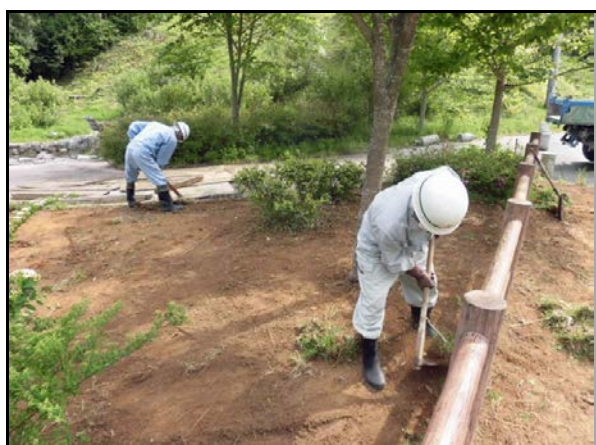
除染作業状況(公園施設)
