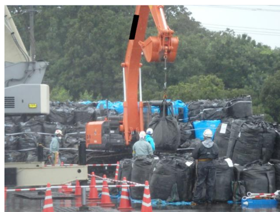
除去土壌の積下ろし作業
