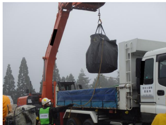
除去土壌の積み込み作業
