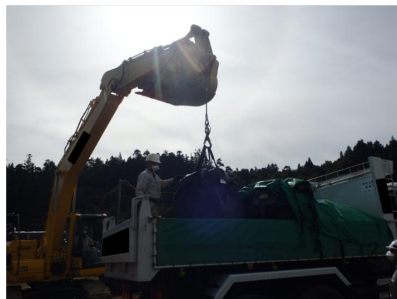
除去土壌の積み込み作業
