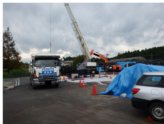
除去土壌の積下ろし作業
