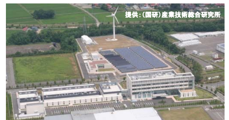
福島再生可能エネルギー研究所
