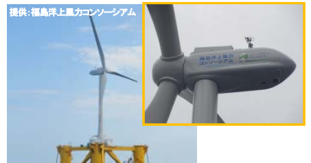
浮体式洋上風力発電実証研究事業
