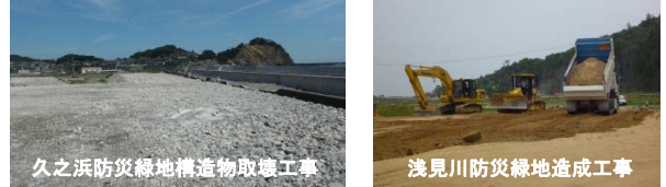
防災緑地造成工事の様子（久之浜、浅見川防災緑地）
