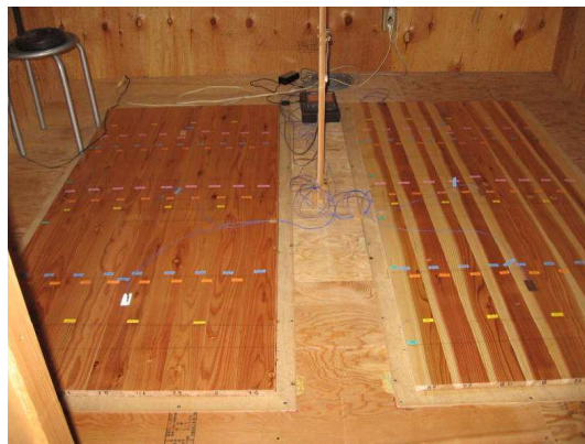
写真－4 床暖房用フローリング設置状況
