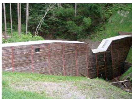
写真-18 単木落とし込み型（H鋼型）施工状況
