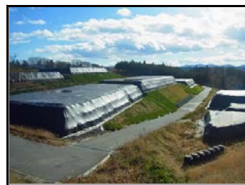
長屋地区仮置場
