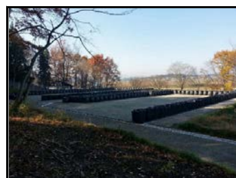
久来石地区仮置場（搬入前）
