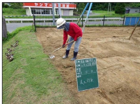
校庭除染工事表土剥取
