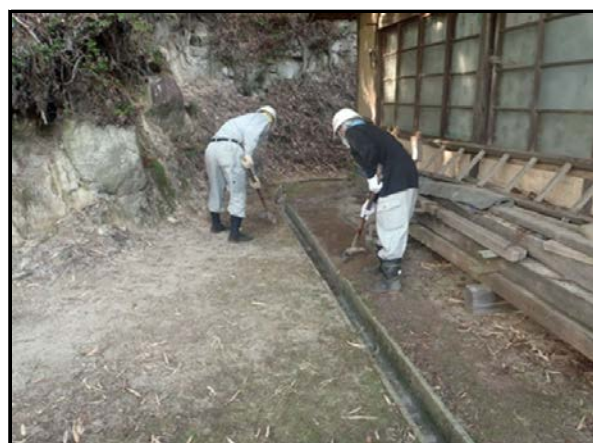
除染実施状況
