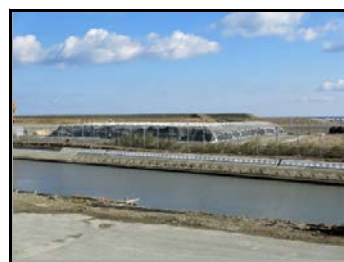
土のう設置状況
