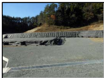
仮置場保管状況
