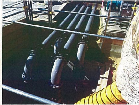
写真② 地下水BP→B排水路への移送配管設置状況
