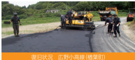
復旧状況 広野小高線(楡葉町)
