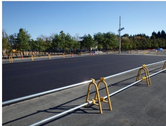
保管場の舗装状況の確認
