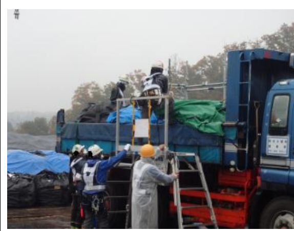
除去土壌等の積み込み作業
