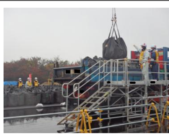
除去土壌等の積下ろし作業
