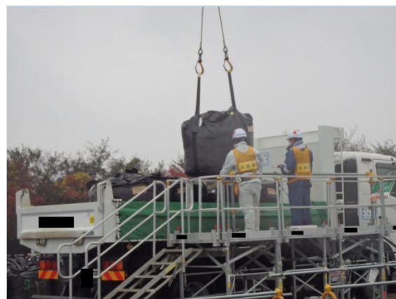
除去土壌等の積下ろし作業
