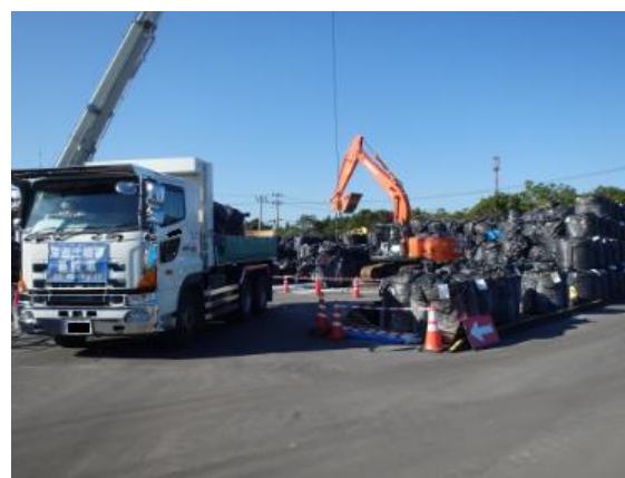
除去土壌等の積下ろし作業
