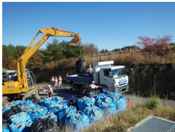
除去土壌等の積み込み作業
