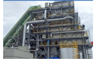
浪江町仮設焼却炉
