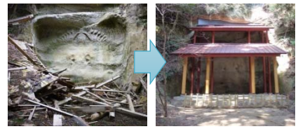
観音堂石仏の復旧(南相馬市)
