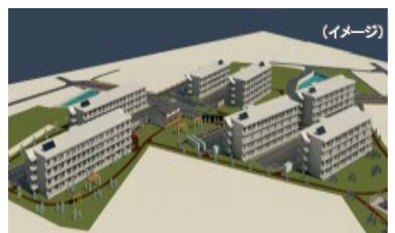
復興公営住宅(南相馬市 北原団地)
