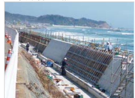
海岸堤防の整備(いわき市永崎地区)
