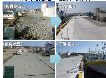
松川浦漁港の復旧(相馬市)
