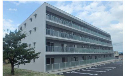
復興公営住宅(福島市 飯坂団地)
