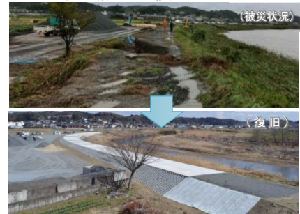
阿武隈川の復旧(矢吹町)
