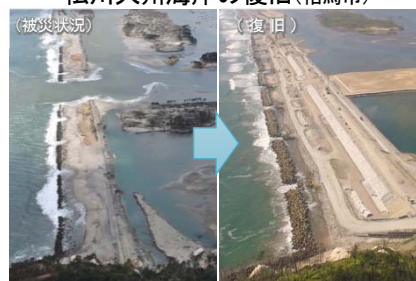
松川大州海岸の復旧(相馬市)
