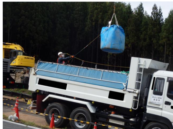
除去土壌等の積み込み作業
