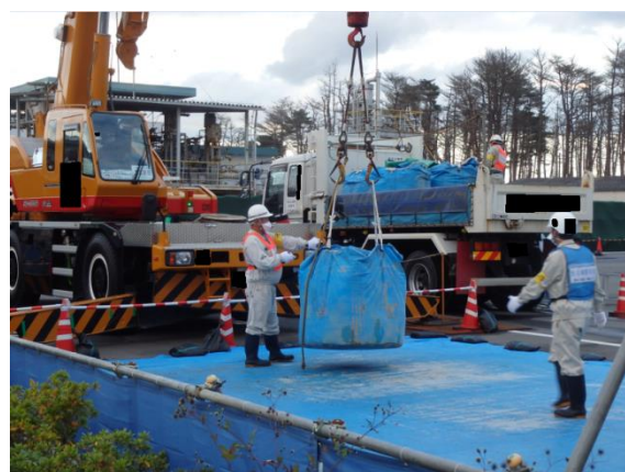
除去土壌等の積替え作業
