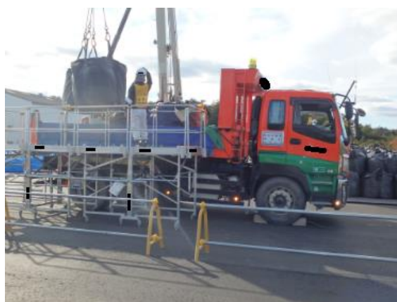
除去土壌等の積下ろし作業
