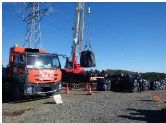
除去土壌等の積み込み作業
