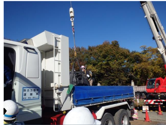
除去土壌等の積み込み作業
