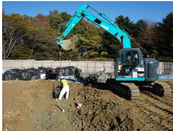
フレキシブルコンテナの掘り起こし作業
