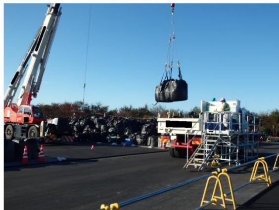
除去土壌等の積下ろし作業
