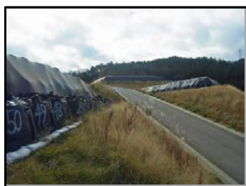
和田地区仮置場
