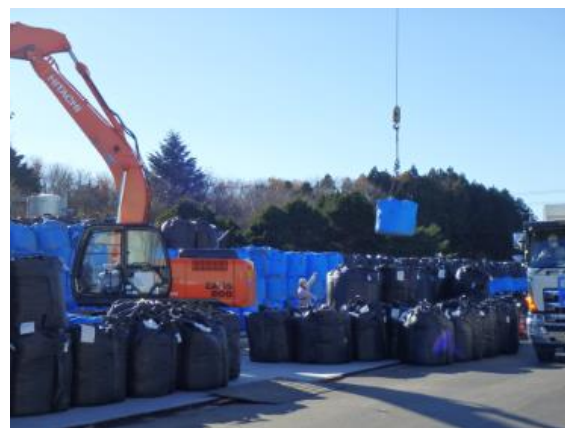
除去土壌等の積下ろし作業
