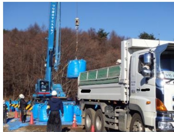
除去土壌等の積み込み作業
