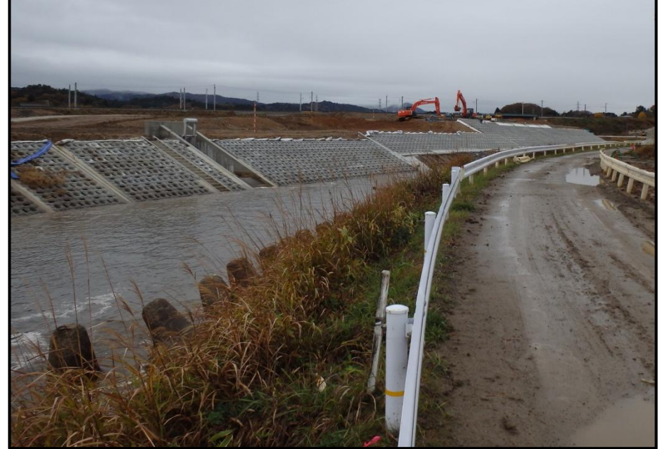
「10009 河川 北迫川」の施工状況
